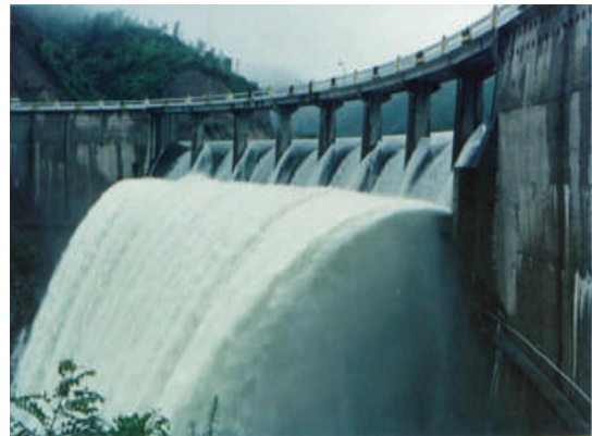
Сл.3.12. Површински прелев; со осум прелевни полиња (над нив мост); водата бурно тече низ краток брзотек и ски отскок
