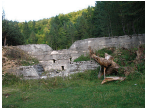
Сл.5.19. Бетонска преграда
