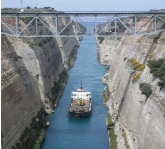
Сл.6.10.Коринтски канал, засечен во карпа е долг 6,3 km со водено огледало 21m а најголема широчина 85m
