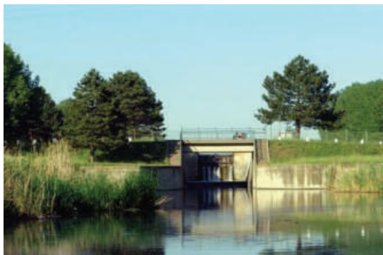
Сл.7.11.Отвор со затворувач кон ретензија
