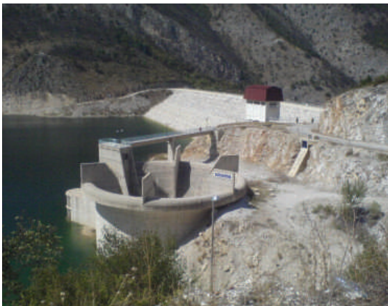
Сл.3.18.Шахтен прелевник: инка и опслужен мост на ХЕЦ“Козјак“
