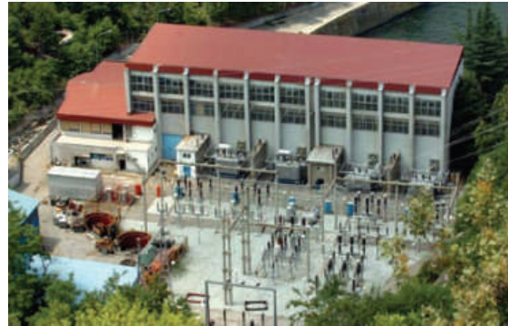
Сл.3.24.Деривациска машинска зграда
