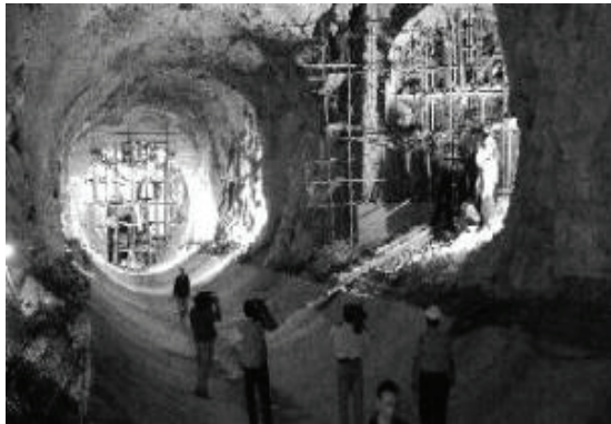
Сл.3.11. Пренамена на дел од оптичниот тунел (6) во одводен тунел (7) на шахтен прелев кај ХЕП “Турија“
