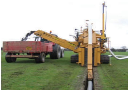
Сл.8.10.Механизирано поставување на цевка за подземно наводнување
