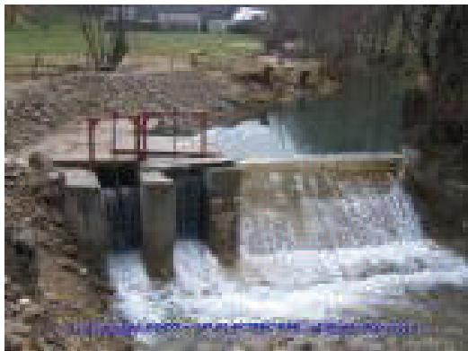
Сл.8.12. Устава и прелев на канал
