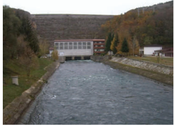
Сл.1.13.Оската на круната на браната и машинската зграда се паралелни кај ХЕЦ “Шпиље“
