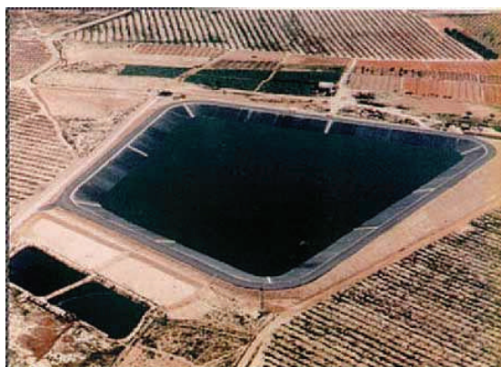
Сл.7.3 Базен, ретензија, за чување на вода за наводнување
