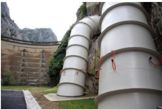
Сл.1.9.Цевовод под притисок
