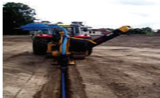
Сл.9.13 Паралелно копање на ров и поставување на пластични цевки
