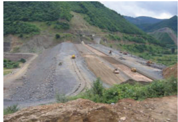
Сл.2.4.Распстилање и набивање
