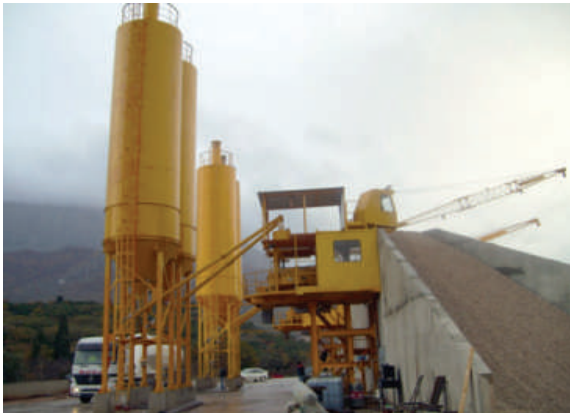
Сл.2.12. Фабрика за бетон
