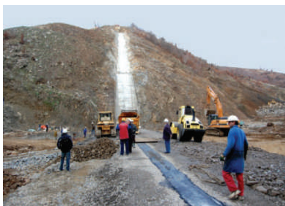
Сл.2.9.Вградување на дијафрагма од асфалт на брана “Кнежево“
