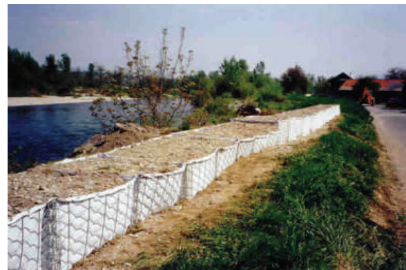
Сл.6.7.Надвишување со контејнери од жичана мрежа полни со земја
