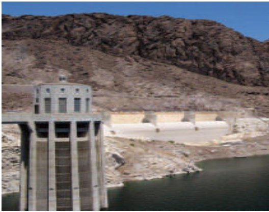
Сл.3.17.Бочен прелев на брегот покрај брана (во заден план).
